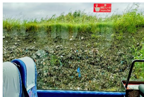
ゴミと土のサンドイッチ工法
